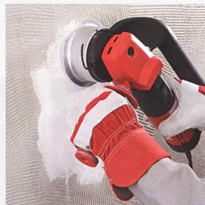
La testa di fresatura con le sue 12 rotelle dentate in metallo duro è particolarmente indicata per la rimozione di vecchie colle per piastrelle.
