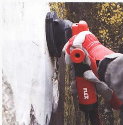
La **RETECFLEX** è anche adatta per il trattamento di vecchie superfici in calcestruzzo disgregato.
